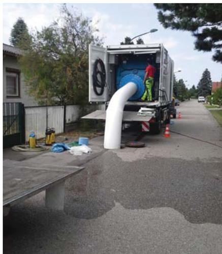
Einziehen des Kanalinliners über die Grillparzergasse in die Feldgasse
